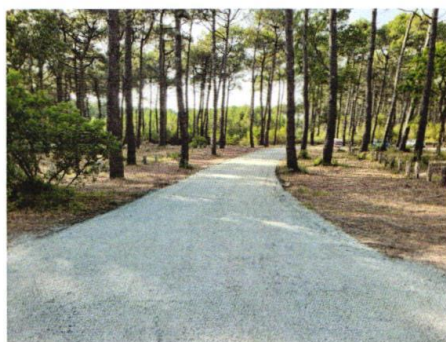
Réfection voirie, La Teste-de-Buch
