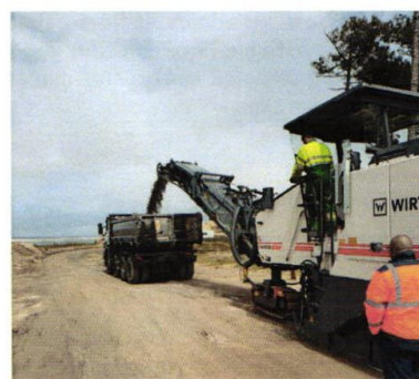
Renaturation de voirie, La Teste-de-Buch
