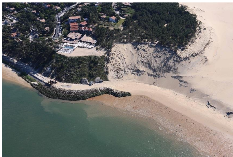
Figure 14 : Photographie aérienne du secteur après mise en œuvre du scénario S3B
