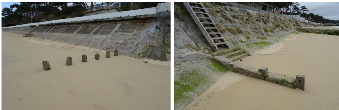
Figure 68. Vestiges d'anciens épis observés sur l'estran (source : CASAGEC - mars 2017).
