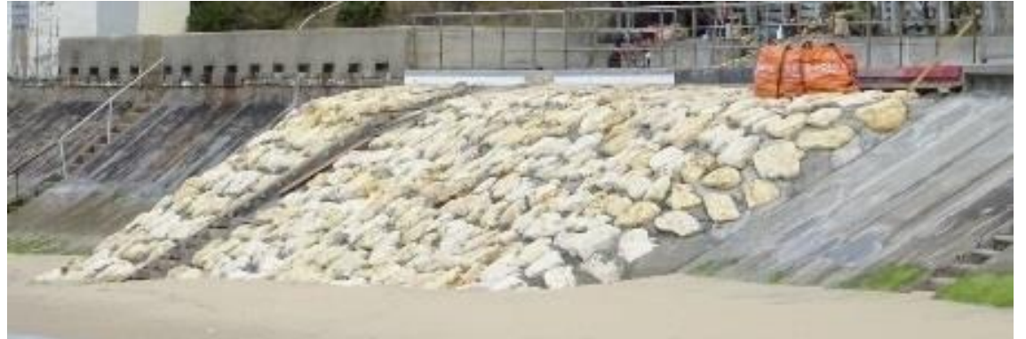
Figure 56. Exemple de perré ayant bénéficié d'une protection en enrochements bétonnés (source : CASAGEC 2017)
