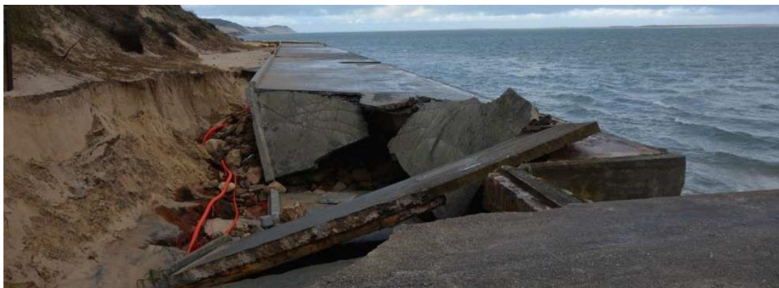
Figure 61. Perré de la Corniche éventré suite à la tempête de février 2016 (source : Sud-Ouest – Sabine Menet).
