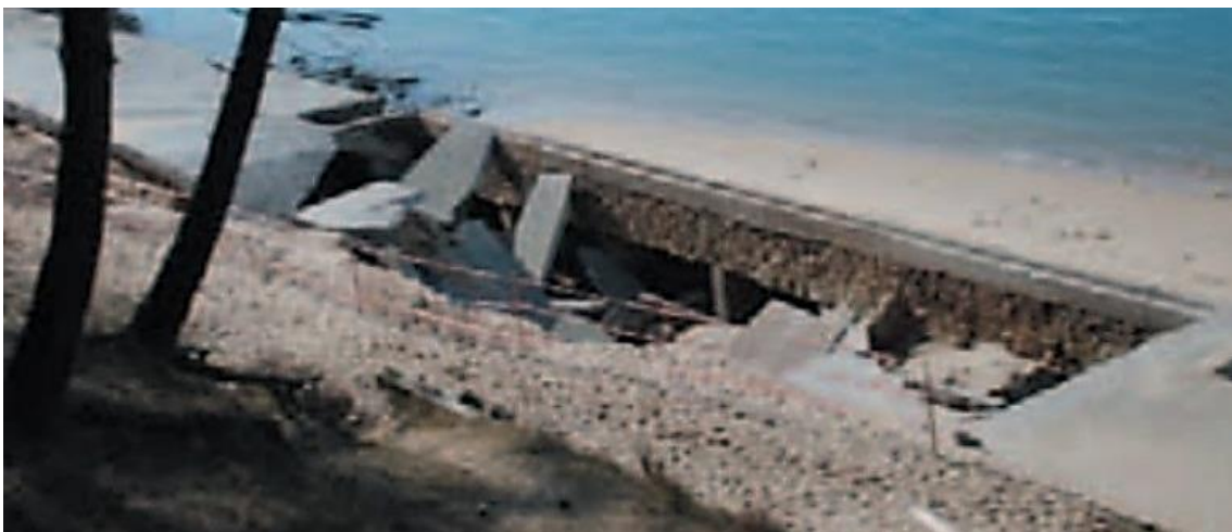
Figure 58. Éventrement d'une partie du perré de la Corniche lors des tempêtes du début 2009.
