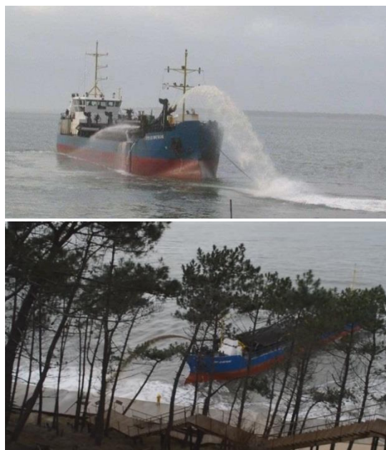
Figure 67. Rechargement des plages du Pyla par le procédé de « Rainbowing ».
