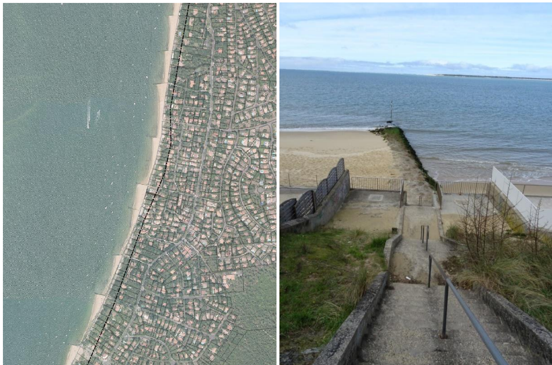
Figure 71. Illustrations de l'effet des épis au Pyla-sur-Mer (orthophotoplan de 2015 à gauche et cliché du 20 mars 2017 à droite).
