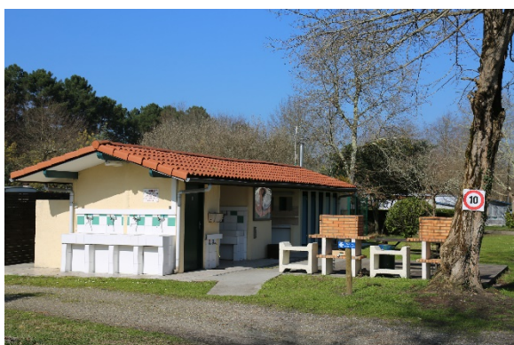
Installation en dur
