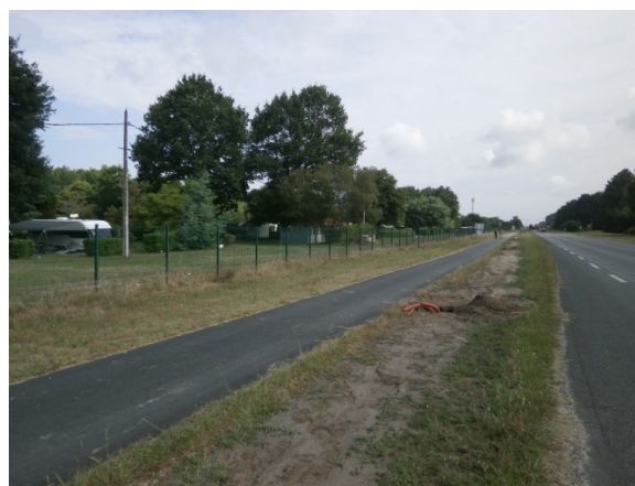
Vue du camping depuis la RD218
