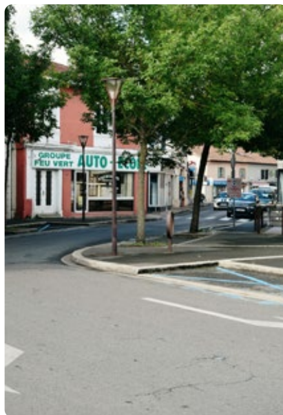
Trottoir en bitume, La Teste de Buch
