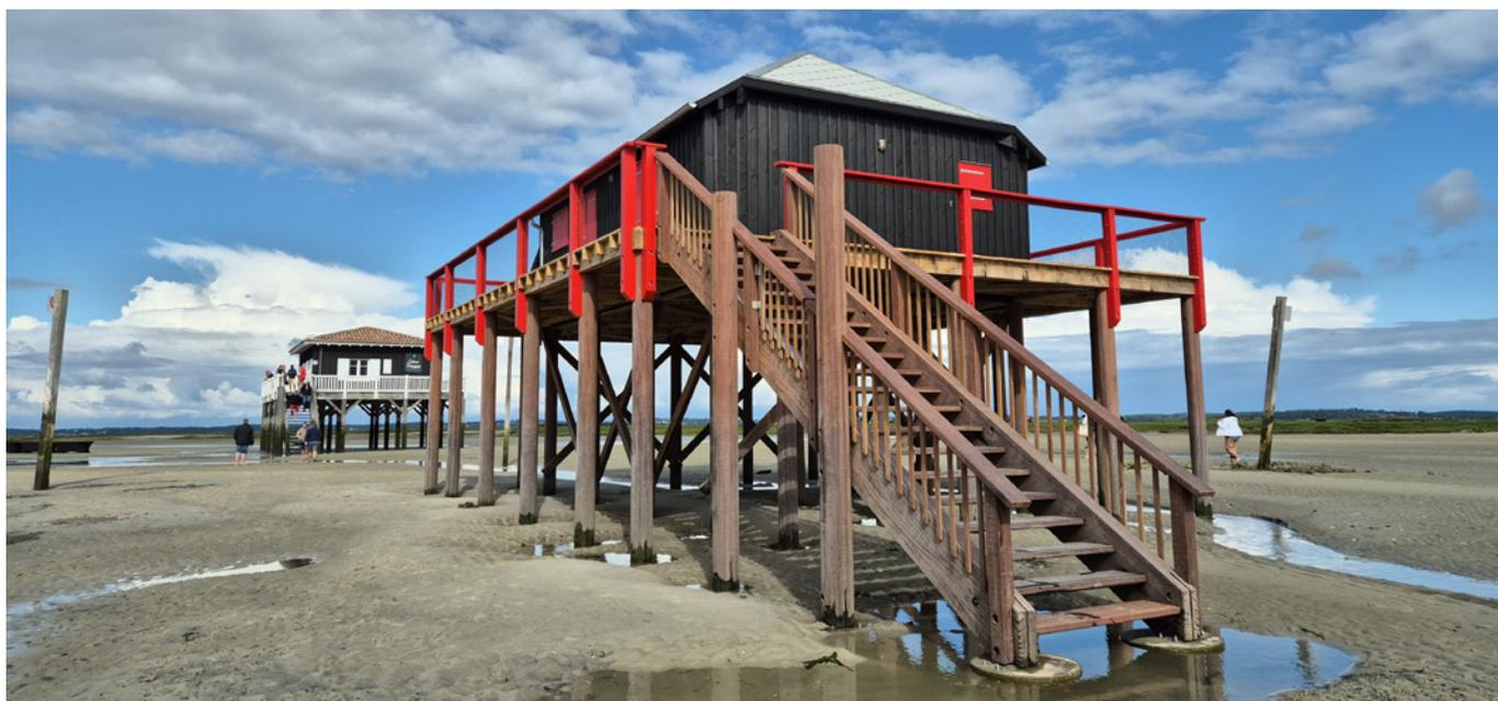
La cabane culmine à 3,70m de hauteur, juchée sur des pilotis en azobé, un bois exotique seul capable de supporter l'immersion marine et le marnage.
